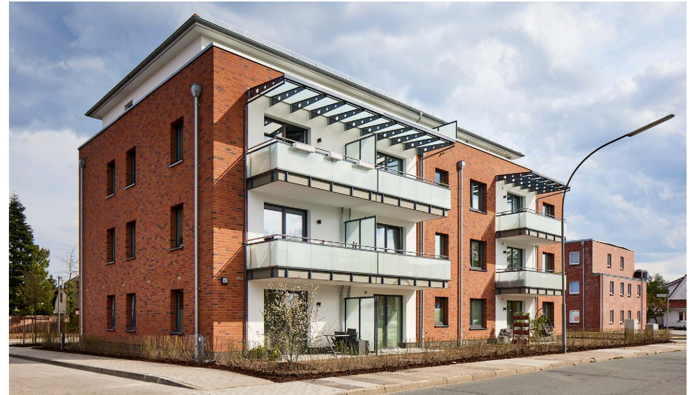
Im Appenstedter Weg in Seevetal-Meckelfeld entstanden zwei Wohngebäude mit insgesamt 22 Wohnungen. Die Wohnungen wurden am 01.03.2023 bzw. 01.04.2023 an die Mitglieder übergeben.
