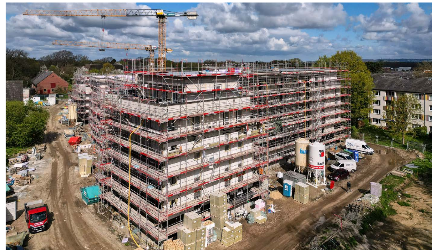
In der Weidenkehre 20 in Neugraben-Fischbek konnte im 1. Quartal 2022 mit den Bauarbeiten begonnen werden. Es wird ein öffentlich gefördertes Gebäude mit insgesamt 45 Wohnungen, einem Gemeinschaftsraum und 9 Tiefgaragenstellplätzen errichtet.
